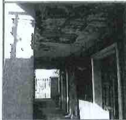
esterno villa, p.lla n. 431, porticato
