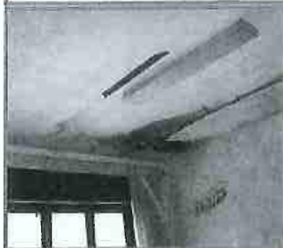
Interno uffici, p.la n. 683 sub 1
