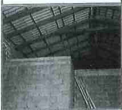
Interno deposito posteriore, p.lla n. 683 sub 4
