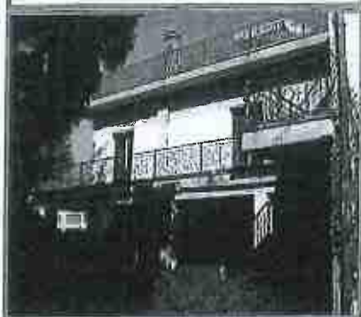
prospetto sud villa, p.lla n. 431
