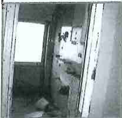
Interno villa, p.la n. 431, piano primo
