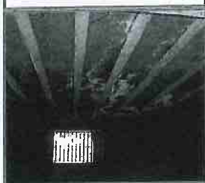
Interno deposito posteriore, p.lla n. 683 sub 4
