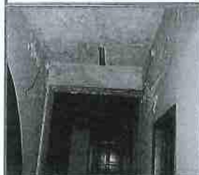
interno villa, p.lla n. 431, piano terra
